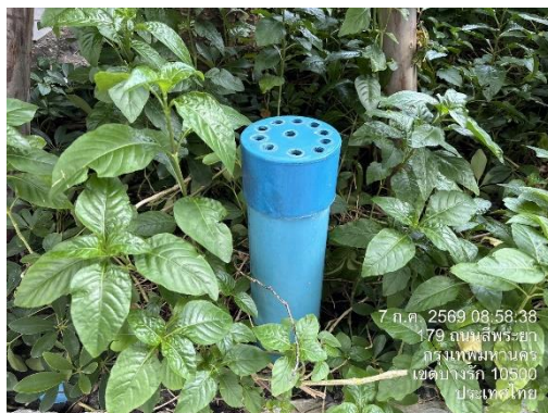
ภาพที่ 2.2-8 บ่อดินกำจัดก๊าซมีเทน
